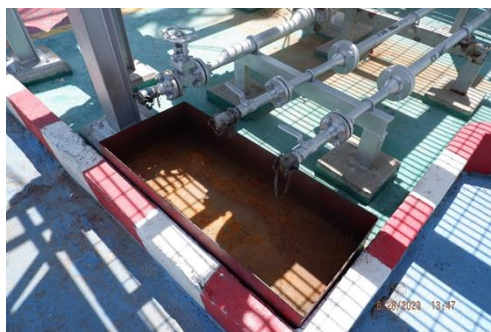
ภาพที่ 2-5 ถาดรองน้ำมันที่อาจหกรั่วไหลจากการถอดท่อและข้อต่อในการขนถ่ายน้ำมันที่ท่าเรือ
