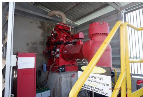
ภาพที่ 2-10 (ต่อ) อุปกรณ์ดับเพลิงภายในคลัง
