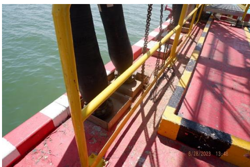
ภาพที่ 2-5 ถาดรองน้ำมันที่อาจหกรั่วไหลจากการถอดท่อและข้อต่อในการขนถ่ายน้ำมันที่ท่าเรือ
